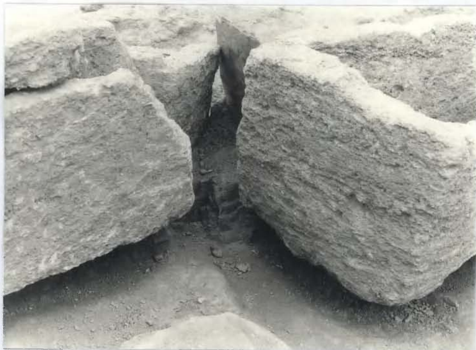
7: traces de layage sur T.8 et T.9 (groupe 1).
