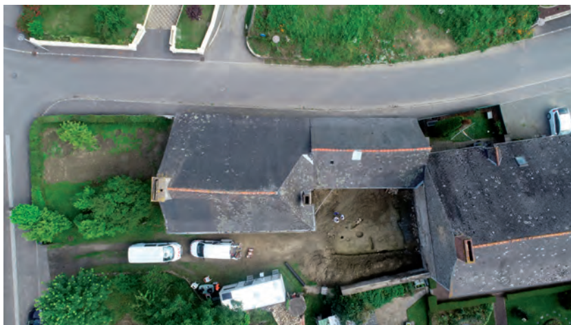
Fig. 28 Vue zénithale des deux corps de bâtiments du 7 chemin de la chapelle Saint-Pierre © J. Conan, Inrap
