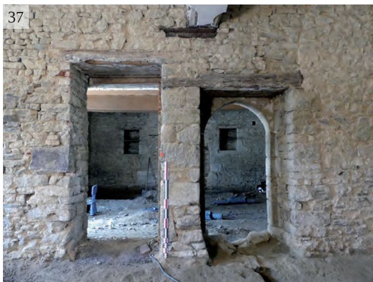
Fig. 37 Vue des deux portes ouest du rez-de-chaussée, côté intérieur. Un empochement est bien visible sur l'extrémité sud du linteau de la porte nord © M. Millet, Inrap
