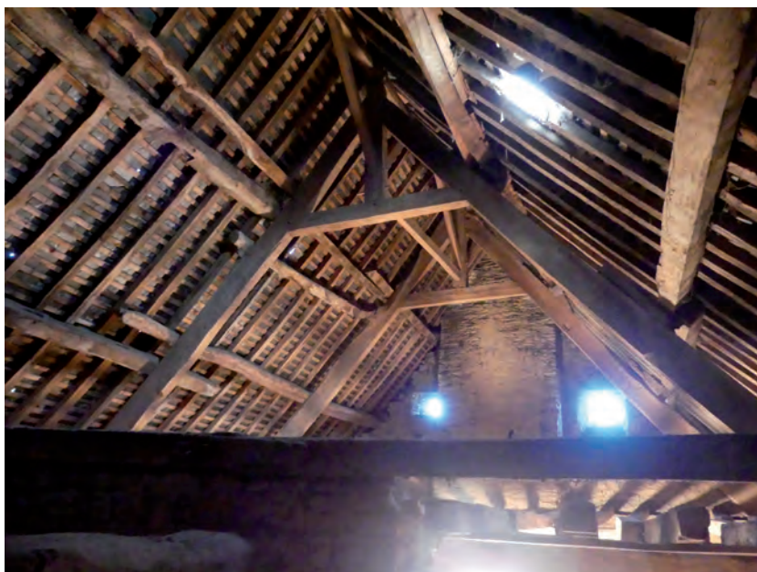
Fig. 60 Vue des deux fermes ouest de la charpente de la maison principale © M. Millet, Inrap
