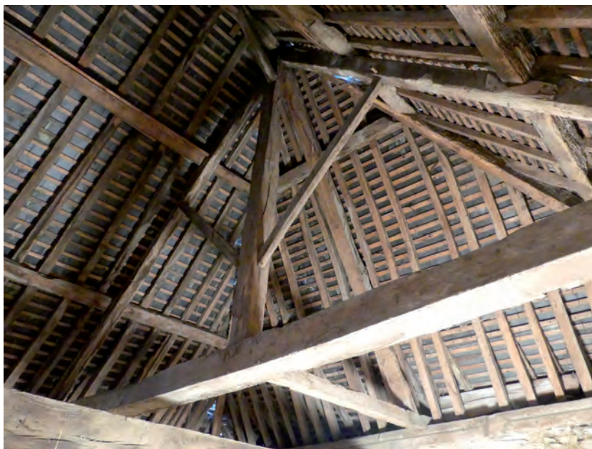
Fig. 59 Vue de la ferme est de la charpente de la maison principale © M. Millet, Inrap
