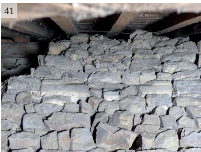
Fig. 39 Vue des empochements d'anciennes solives © M. Millet, Inrap
