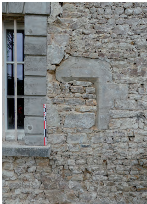
Fig. 47 Vue de la fenêtre 146 à l'extérieur, côté sud © M. Millet, Inrap
