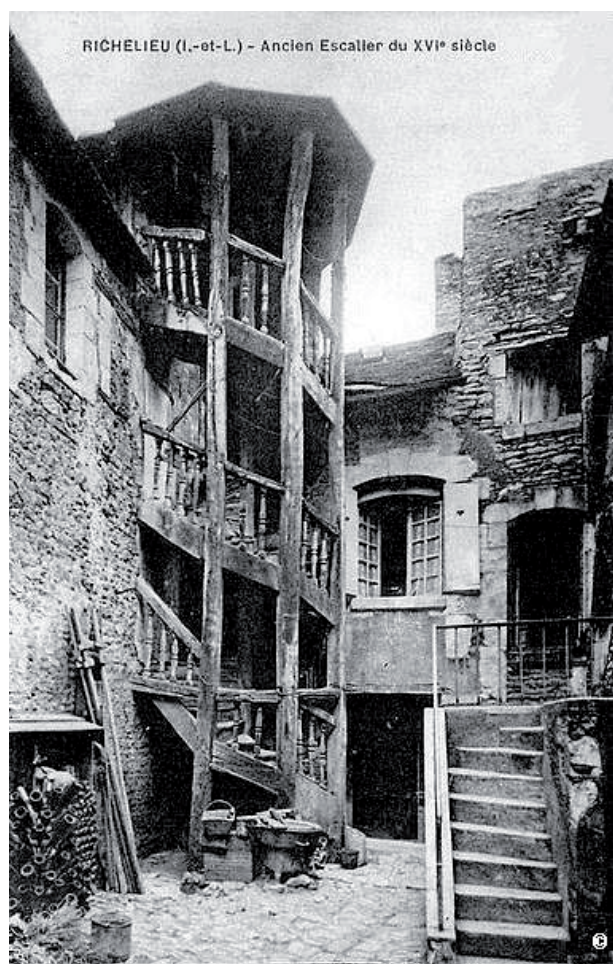
Fig. 43 Exemple d'un escalier en bois hors œuvre. Richelieu (37), XVI e siècle.
