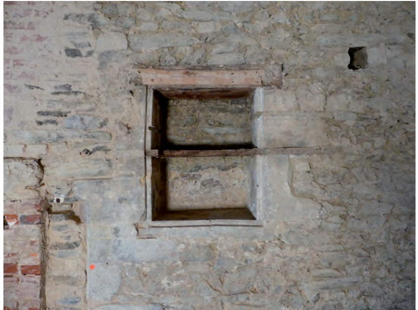
Fig. 56 Vue du placard nord, près de l'ancienne cheminée du rez-de-chaussée © M. Millet, Inrap
