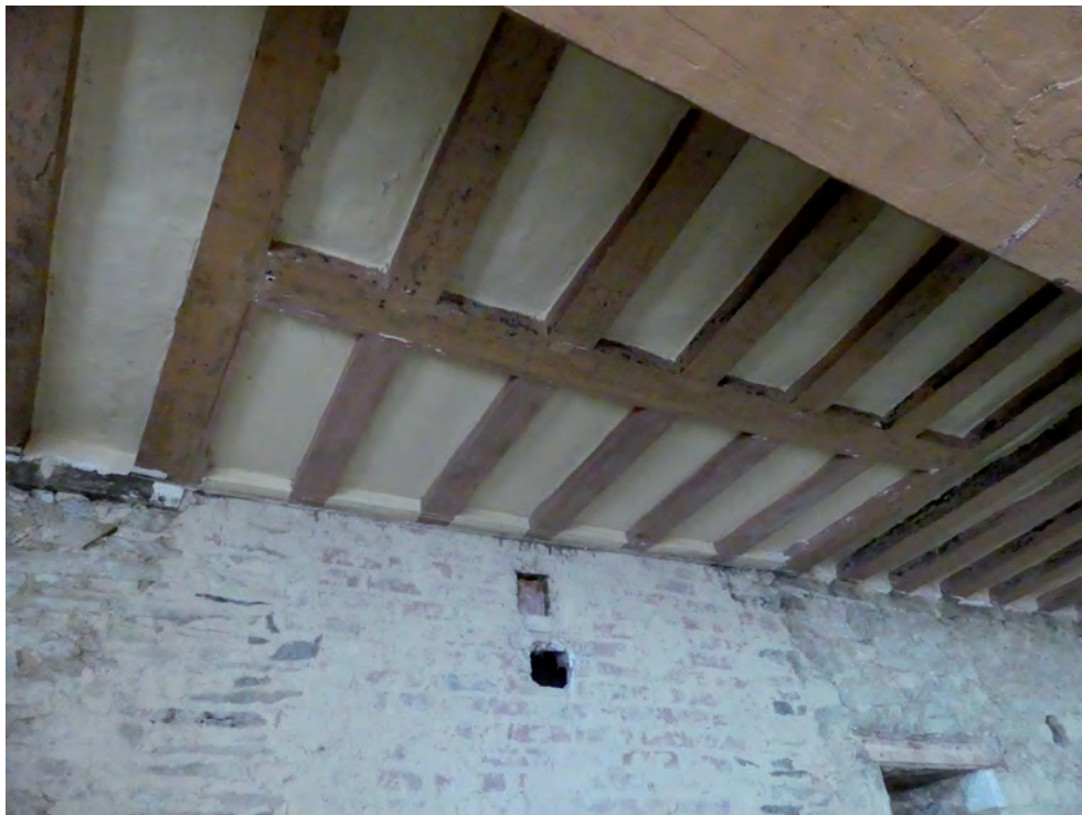
Fig. 55 Vue de l'ancien chevêtre dans le solivage du premier niveau de la première extension © M. Millet, Inrap
